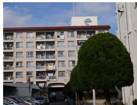
外断熱改修した京都市内の分譲マンション
